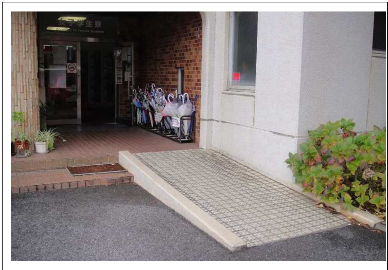
3 玄関(スロープ)
