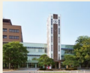
現在の附属図書館建物
